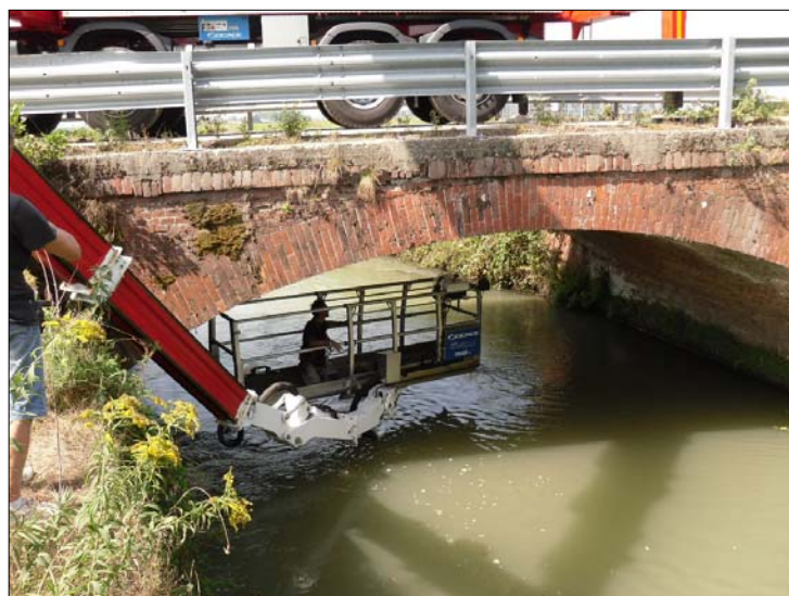
Fig.8: ancora mattoni mancanti in prossimità del piano viario
