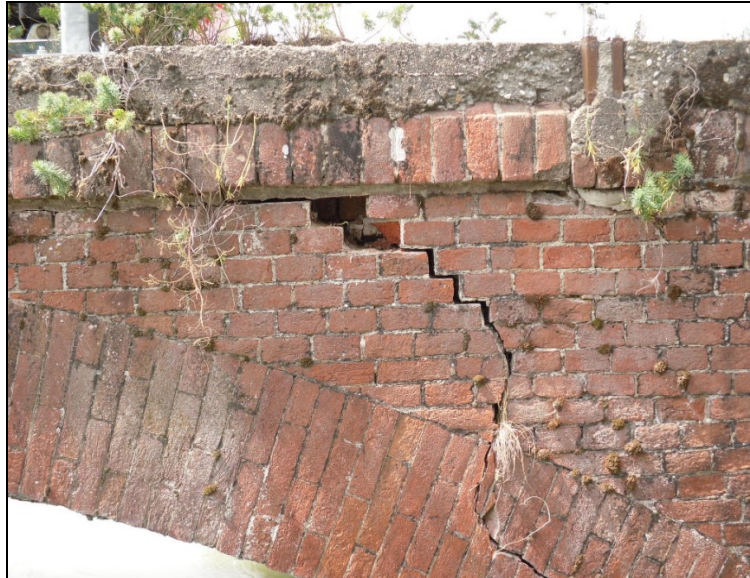
Fig.17: prelievo campioni di mattoni da sottoporre a prova. Da notare la significativa fessurazione timpano lato Robbio
