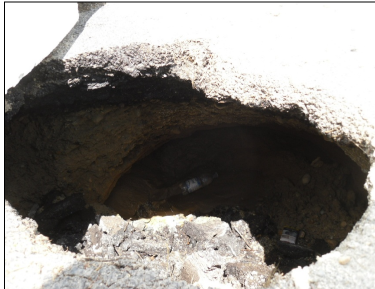
Fig.11: cedimento stradale in corrispondenza della spalla lato Robbio
