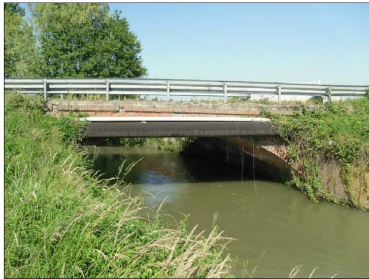
Fig.7: mattoni mancanti in prossimità del piano viario
