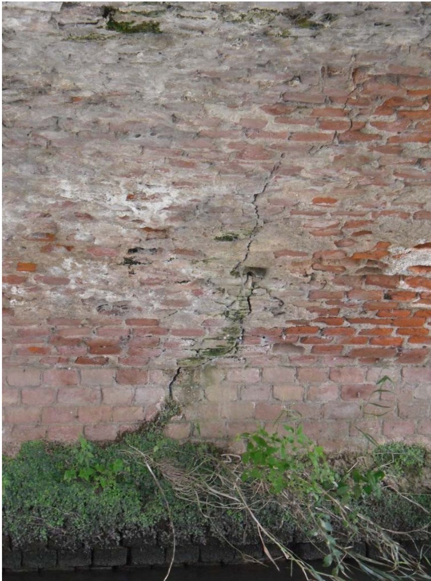
Fig.6: lesione longitudinale volta
