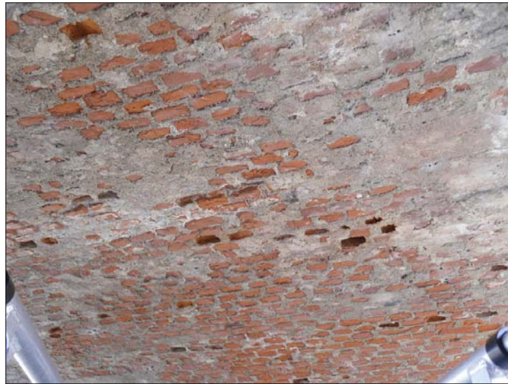
Fig.9: mattoni mancanti intradosso volta assieme a fenomeno esfoliativo
