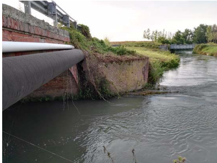
Fig.19: muro d'ala spalla idrografica sinistra a valle
