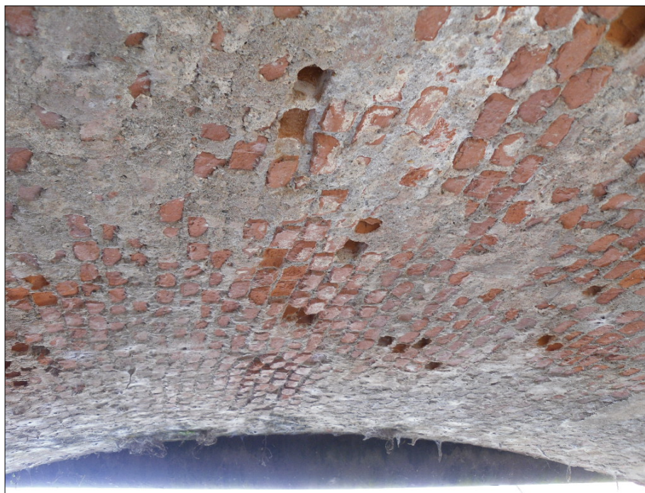
Fig.10: ancora mattoni mancanti intradosso volta assieme a fenomeno esfoliativo
